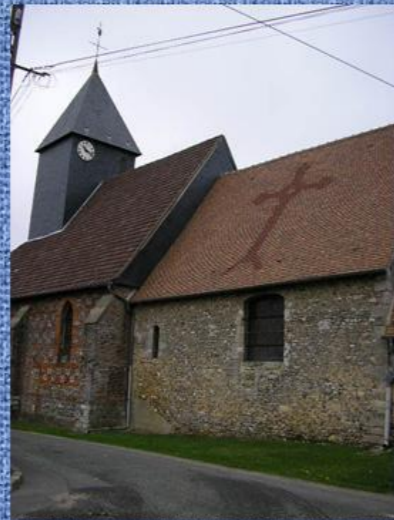
Croix sur la toiture de l'église
