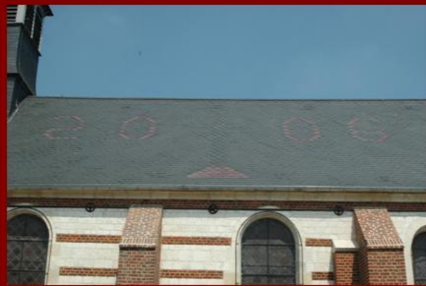
Toiture de l'église
