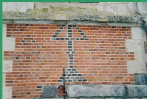
Croix en briques sur mur Cœur de la chapelle
